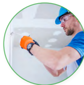
Instalación y puesta en marcha
