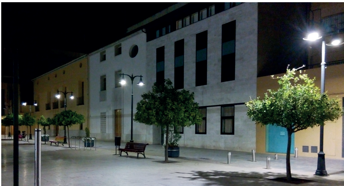
Street lighting 📍 Catarroja (Valencia)
