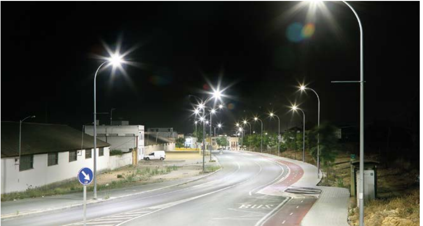
Alumbrado público 📍 Marinera de Alcor (Sevilla)
